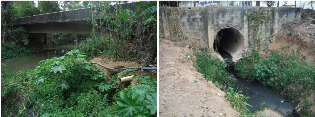
Figura 9.11 – Lançamento P-11 e P-12.
