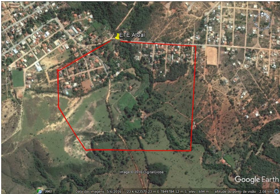
Figura 5.3- Vista da área a jusante da atual ETE.
