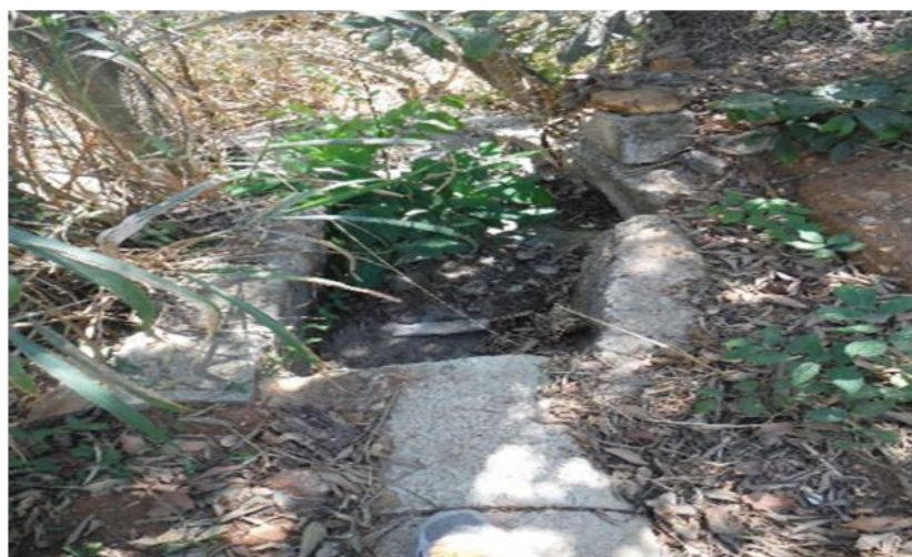
Figura 9.5 – P08: Descarga de drenagem próxima ao lançamento interceptor.
