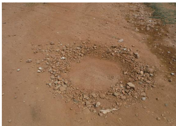
Figura 9.18 – Vista de PV recoberto pelo pavimento.
