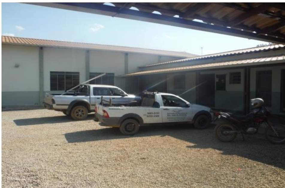
Figura 5.8 – Instalações da AMSJA.
