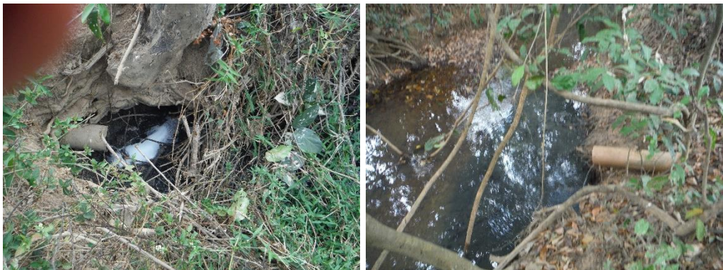
Figura 9.12 – Lançamento P-14 e P-15.
