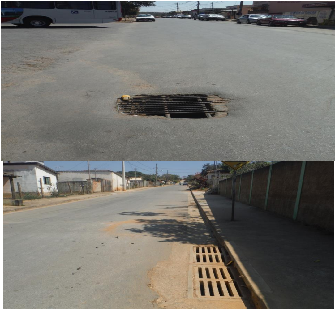
Figura 5.13 – Boca de Lobo – fora de padrão e padronizada.
