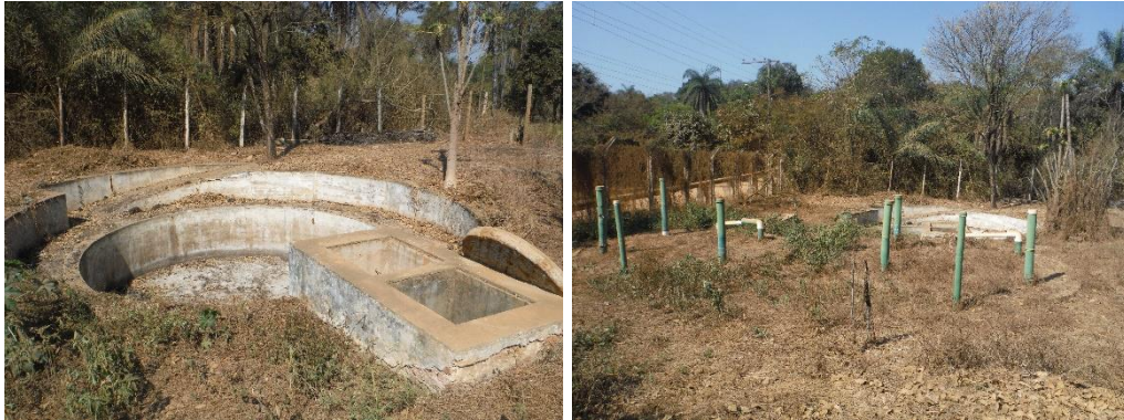
Figura 5.2 – Vista 1: Leito de Secagem e Vista 2: Visão geral.
