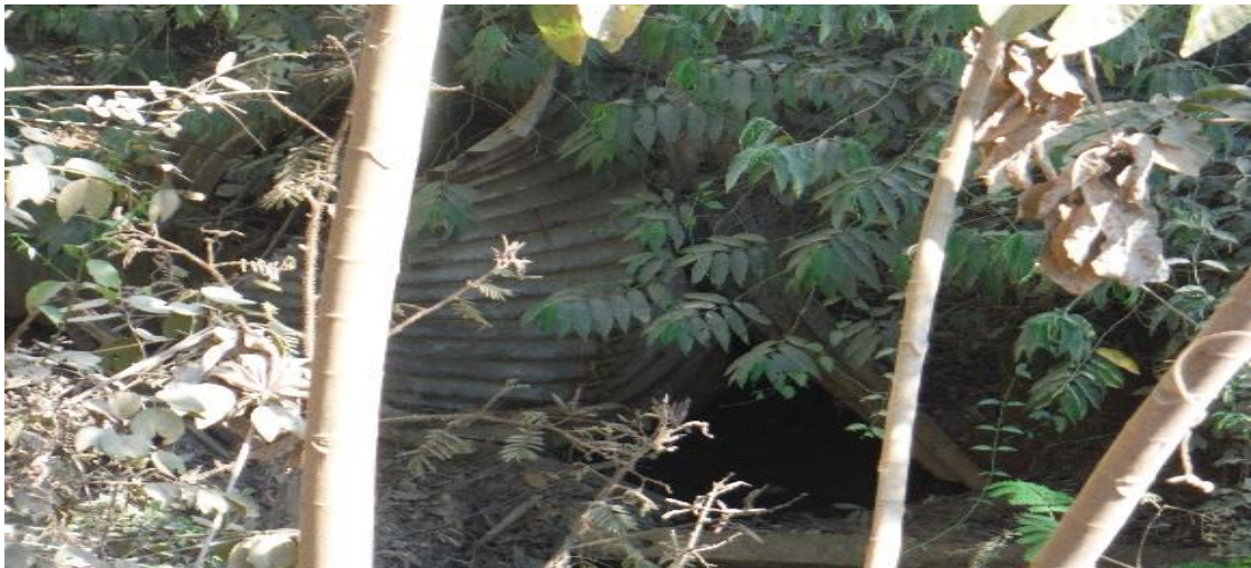
Figura 5.4- Lançamento ETE no Córrego São José.
