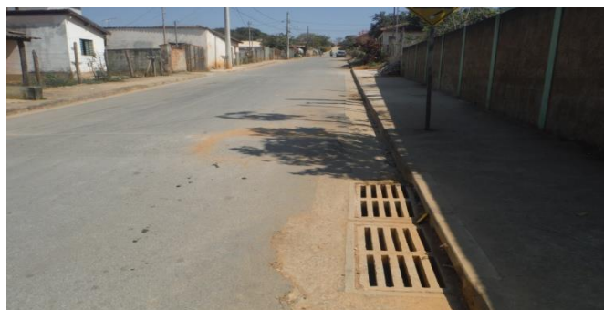
Figura 5.9 – Vista de pavimento com greide definido e dispositivo de drenagem alinhado.
