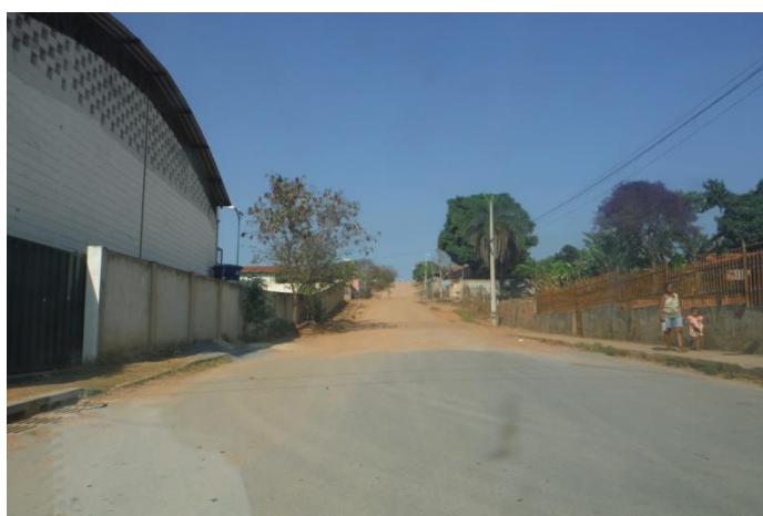
Figura 5.10 – Via urbana com pavimento definido seguido por trecho em subleito.
